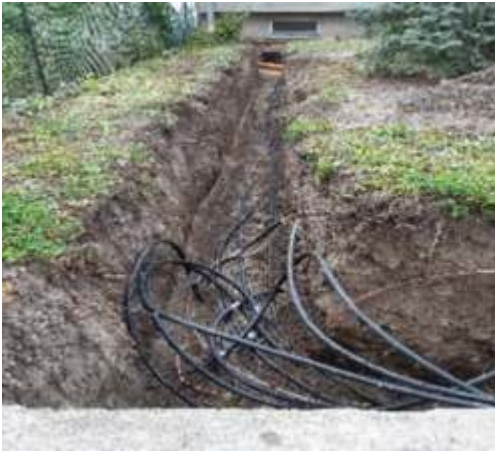
Verlegen der Strom- und Postfreileitungen in die Erde und Anschließen eines neuen Regenabwasserrohres an der Gebäudevorderseite
