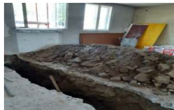
Herstellen eines Putzschachtes im kleinen Pfarrsaal hofseitig
