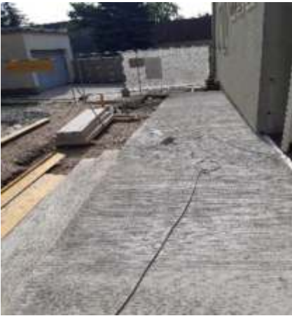
Betonieren der Rampe mit Setzen der Eisen für den Außenstiegenaufgang
