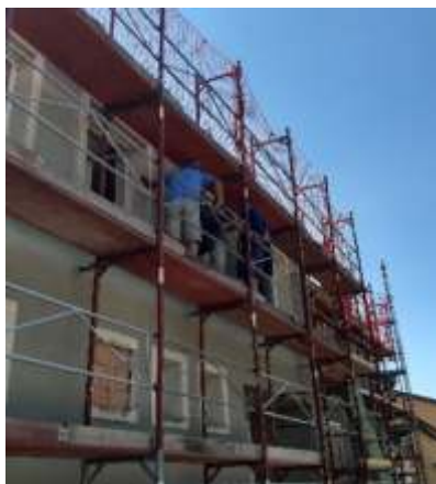
Aufstellen des Gerüstes, Prüfung der Fassadenbeschaffenheit, Abbruch der Dach- und Wandeternitplatten und Pfetten
