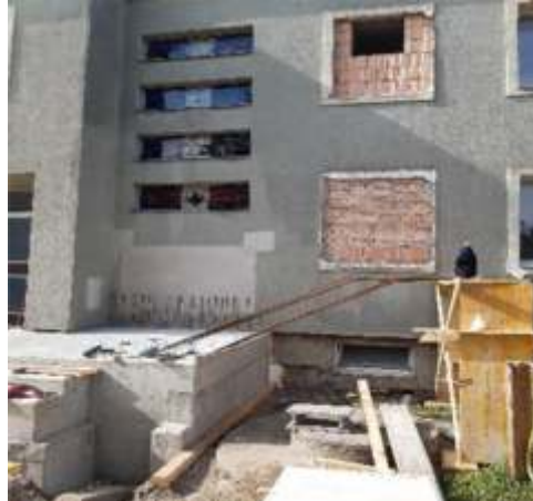
Betonieren der Rampe mit Setzen der Eisen für den Außenstiegenaufgang
