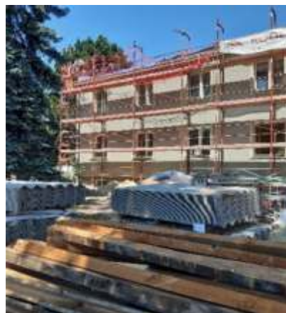
Aufstellen des Gerüstes, Prüfung der Fassadenbeschaffenheit, Abbruch der Dach- und Wandeternitplatten und Pfetten
