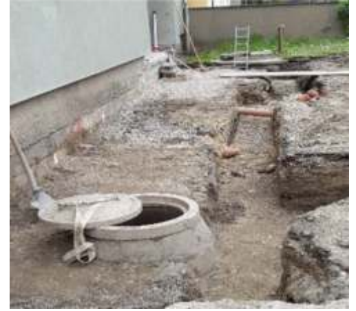
Fundament für Rampe und Verlegen eines neuen Kanalrohres hofseitig
