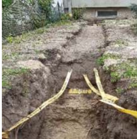
Verlegen der Strom- und Postfreileitungen in die Erde und Anschließen eines neuen Regenabwasserrohres an der Gebäudevorderseite
