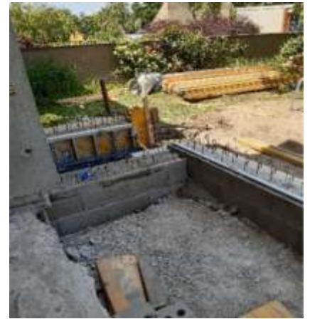
Fundament für Rampe und Verlegen eines neuen Kanalrohres hofseitig
