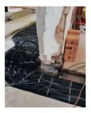
Anbringen der Unterkonstruktion an den Rippen der Kellerdecke für die brandschutztechnische Beplankung, Verlegen der Schläuche für die Fußbodenheizung in den Badezimmern im OG, Verlegen der Verrohrungen auf Promatplatten mit Einziehen der elektrischen Leitungen
